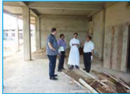
il cantiere nel 2010
