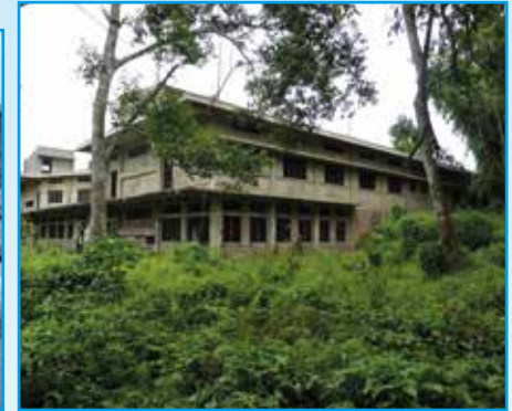
il cantiere nel 2012
