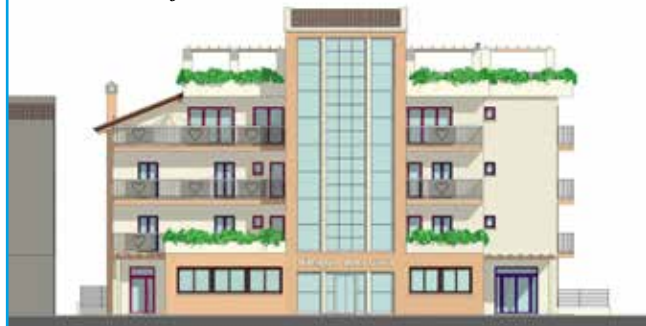
La struttura a fine lavori
